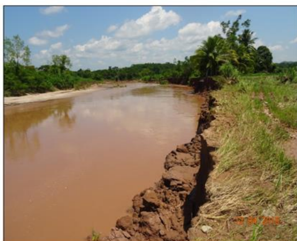
FIGURA N°01: TRAMO CRÍTICO EN EL SISA, QUE SUS CARACTERÍSTICA ARENOSA DE SU RIBERA, SE PRODUCE LA EROSION EN LAS PAREDES DEL TALUD OCASIONANDO SU DESPLOME
